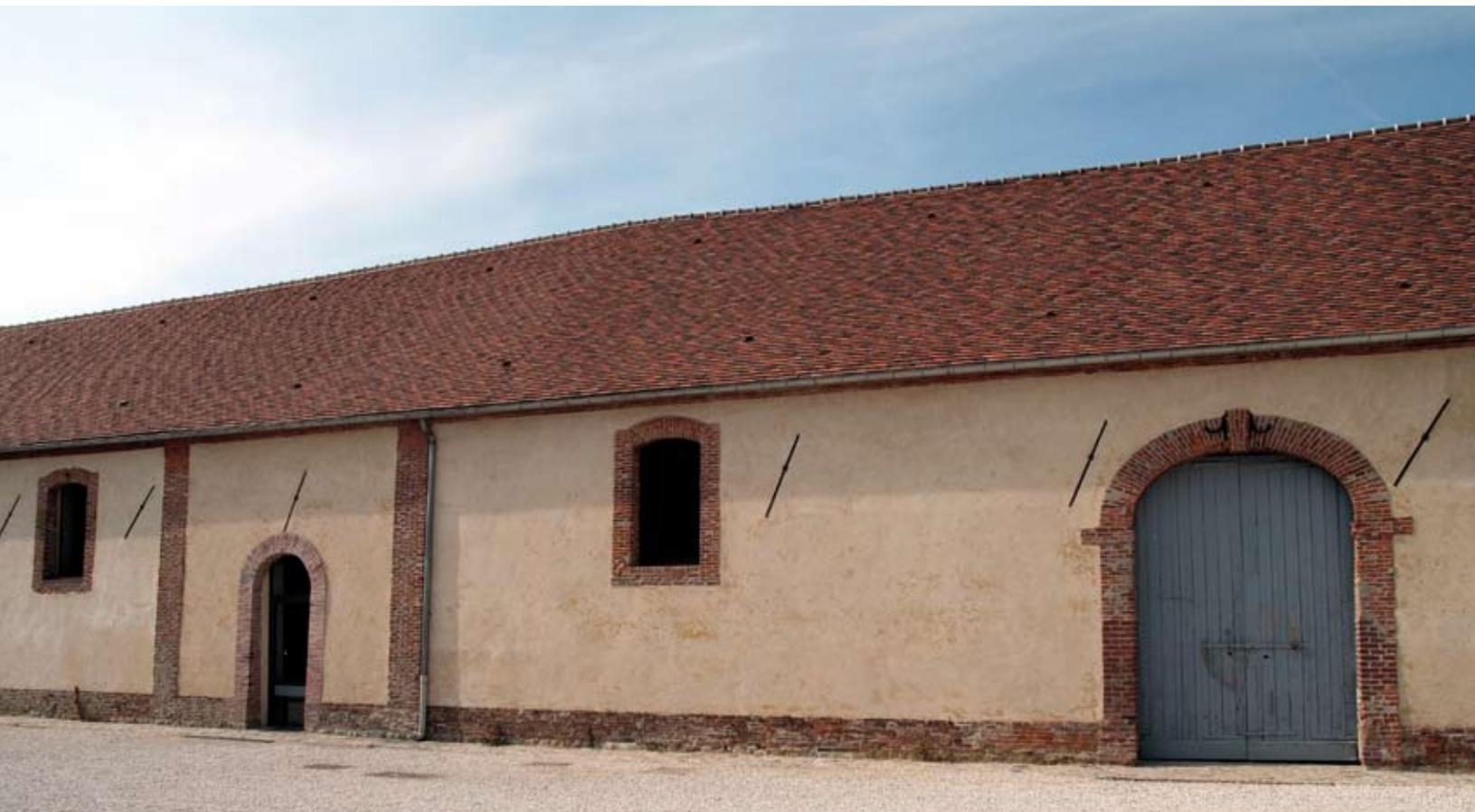
L'Enduit de Montmorency est un plâtre et chaux, fabriqué traditionnellement à partir de plâtre et de chaux aérienne dont la granulométrie, la couleur et la quantité sont choisies sur mesure en fonction des performances et de l'aspect recherché. Cet enduit a un pouvoir exceptionnel d'assèchement et d'assainissement des murs anciens, par ses capacités respiratoires qui protègent tous les éléments du bâti craignant l'eau (bois, hourdis, pisé...) et assurent sa salubrité.
